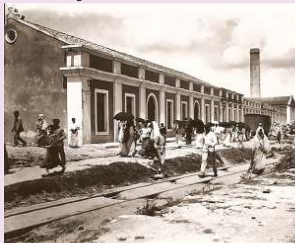
Operários saindo da Fábrica Progresso Alagoana.
