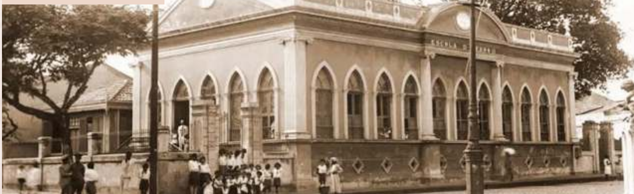
Prédio-sede da Academia Alagoana de Letras nos anos 1930, quando ainda abrigava a Escola D. Pedro II
